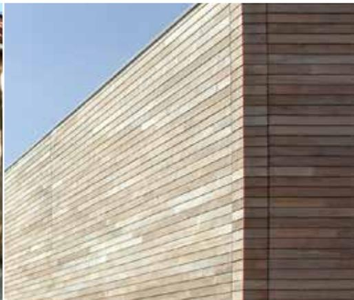
**Horizontale à claire-voie.** Nécessite un pare pluie résistant aux UV et une pose soignée, permet une excellente ventilation des lames. (voir p. 20)
